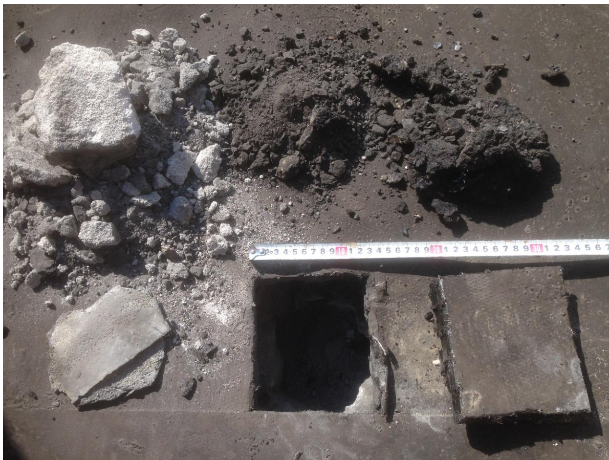
Фото 7 Состав кровли (шурф) .
