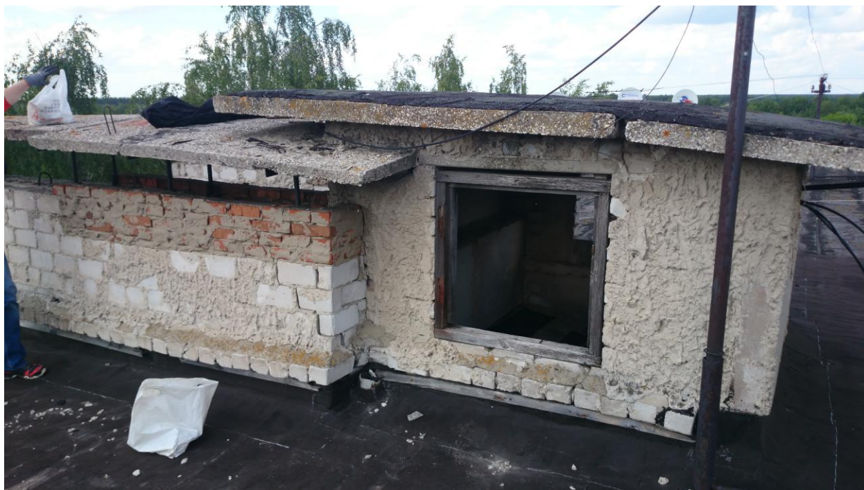
Фото 5 Надстройка над люком выхода на кровлю
